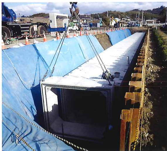
河川工事状況
